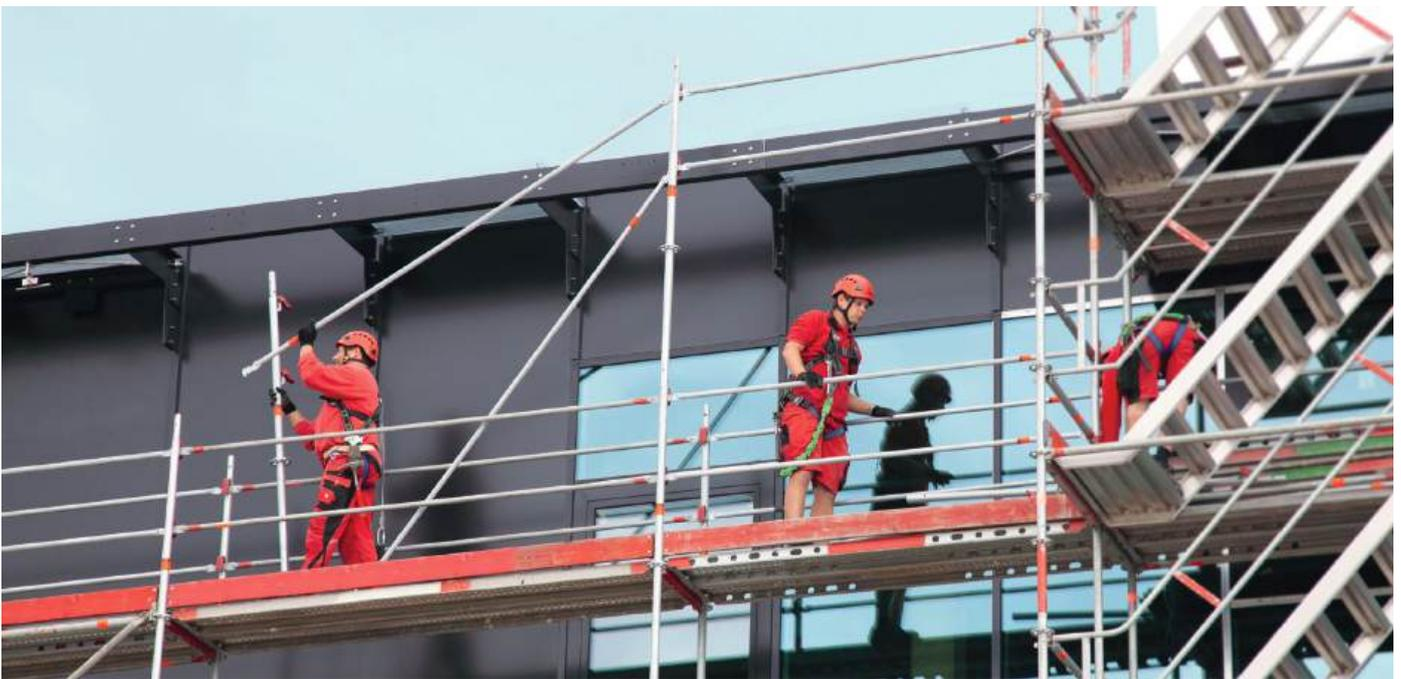
Für einen **vorlaufenden Seitenschutz** ohne zusätzliche Arbeitsschritte hat Layher das modulare Fassadengerüst AGS entwickelt. Durch den AGS-Stiel und das AGS-Geländer erstellen Sie Fassadengerüste im AllroundGerüst mit einem zweiteiligen, vorlaufenden Seitenschutz – sowohl **innen als auch außen** – ohne die Verwendung von temporären Seitenschutzteilen.
