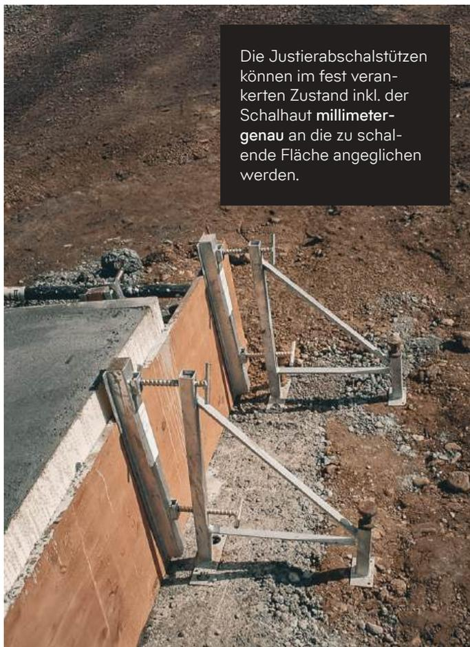
Die Justierabschalstützen können im fest verankerten Zustand inkl. der Schalhaut millimetergenau an die zu schalende Fläche angeglichen werden.
