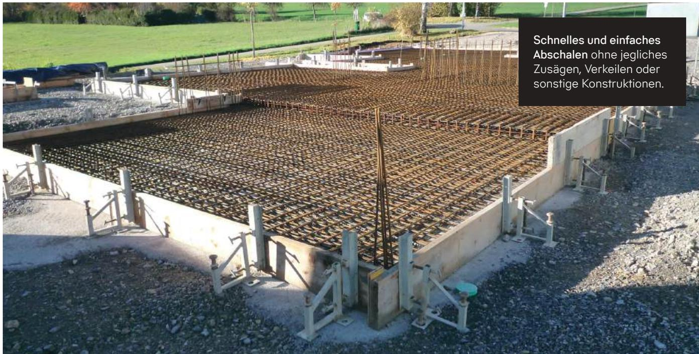
Schnelles und einfaches Abschalen ohne jegliches Zusägen, Verkeilen oder sonstige Konstruktionen.
