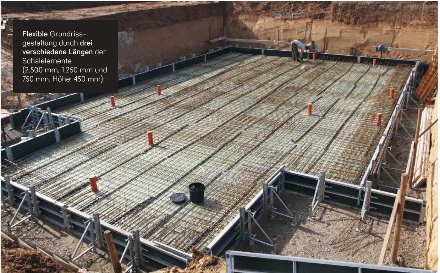
Flexible Grundrissgestaltung durch drei verschiedene Längen der Schalelemente (2.500 mm, 1.250 mm und 750 mm. Höhe: 450 mm).
