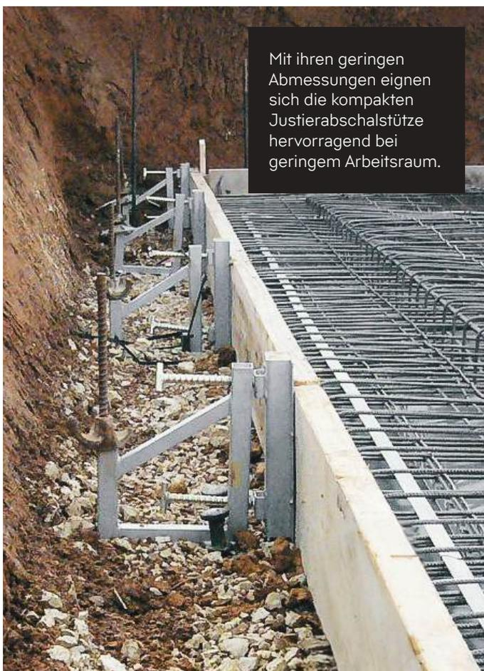
Mit ihren geringen Abmessungen eignen sich die kompakten Justierabschalstütze hervorragend bei geringem Arbeitsraum.
